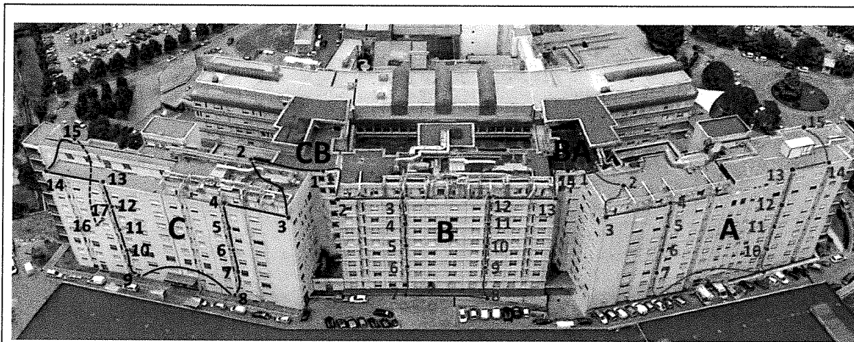
Fig.6 Disposizione punti di misura su immagine prospettica (vista da monte) del monitoraggio dinamico effettuato
